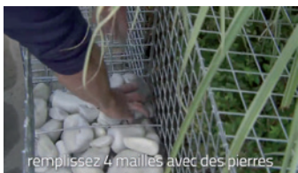
Remplissez 4 mailles avec des pierres et installez deuxième série de tirants en remplissez jusqu'en haut
