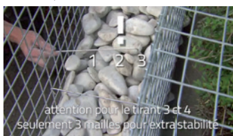
Remplissez 4 mailles avec des pierres et installez deuxième série de tirants en remplissez jusqu'en haut
