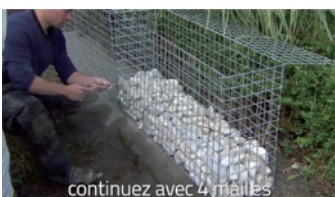
Remplissez 4 mailles avec des pierres et installez deuxième série de tirants en remplissez jusqu'en haut
