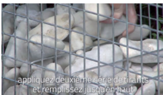
Remplissez 4 mailles avec des pierres et installez deuxième série de tirants en remplissez jusqu'en haut
