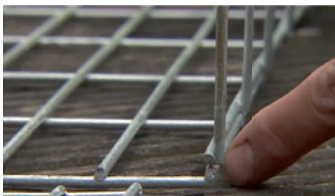
Assemblez les côtés les uns sur les autres
